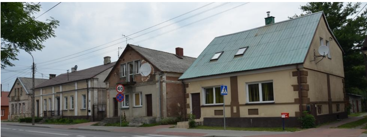
Rys. 14 Zabytkowe budynki przy ul. Łomżyńskiej 30, 32, 43 i 36
