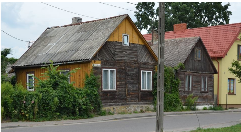
Fot. 10 Drewniana zabudowa przy ulicy Dworskiej
